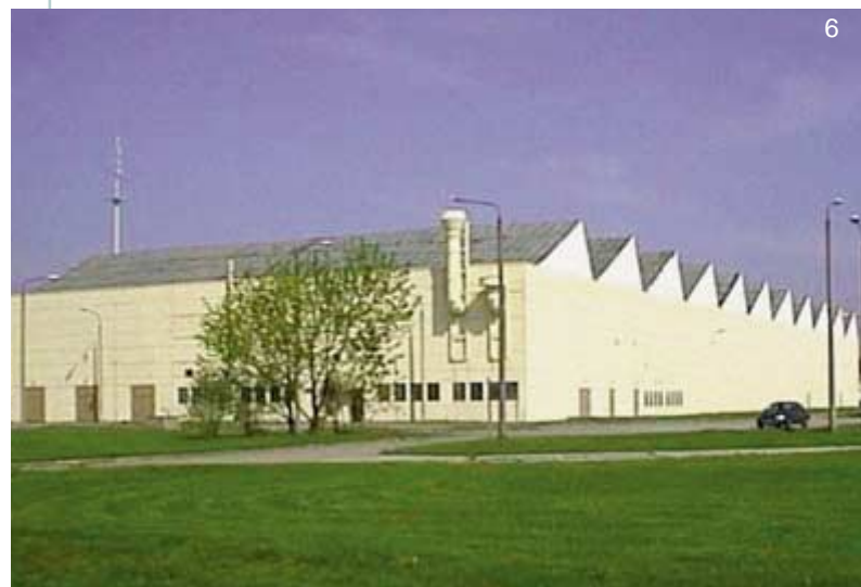
EMDE WUTRA works in Wurzen
